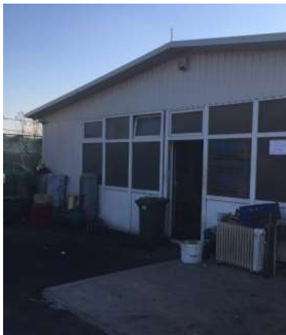
Sabirni bazen za sanitarne i oborinske vode
